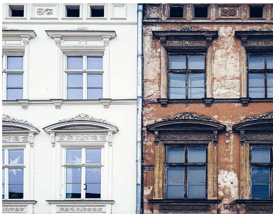
Sanierte Gebäude dienen auch dem Stadtbild.
