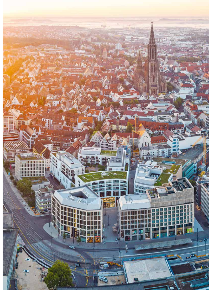
Die Sedelhöfe in Ulm – mitten in der Innenstadt entstand ein neues Mixed-Use-Quartier mit Wohnungen an einem Ort, wo es vorher keine gab.
