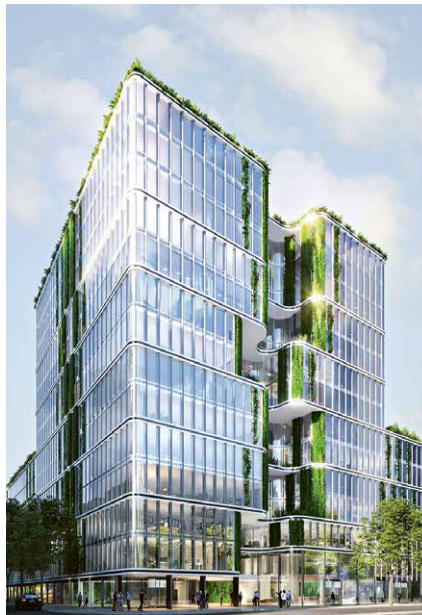
CANYON FRANKFURT CBD – neben einer grünen Fassade und großflächigen Dachgärten werden im CANYON zahlreiche weitere ESG-Maßnahmen implementiert.
