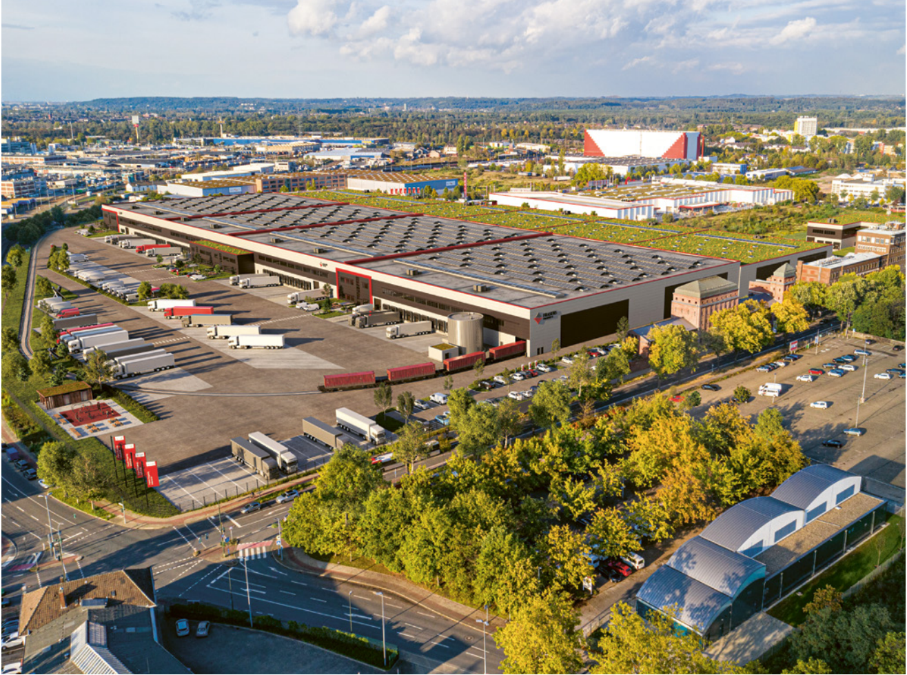
DIE DACHBEGRÜNUNG trägt zur Verbesserung des Mikroklimas bei, und die Photovoltaikanlage liefert grünen Strom.
