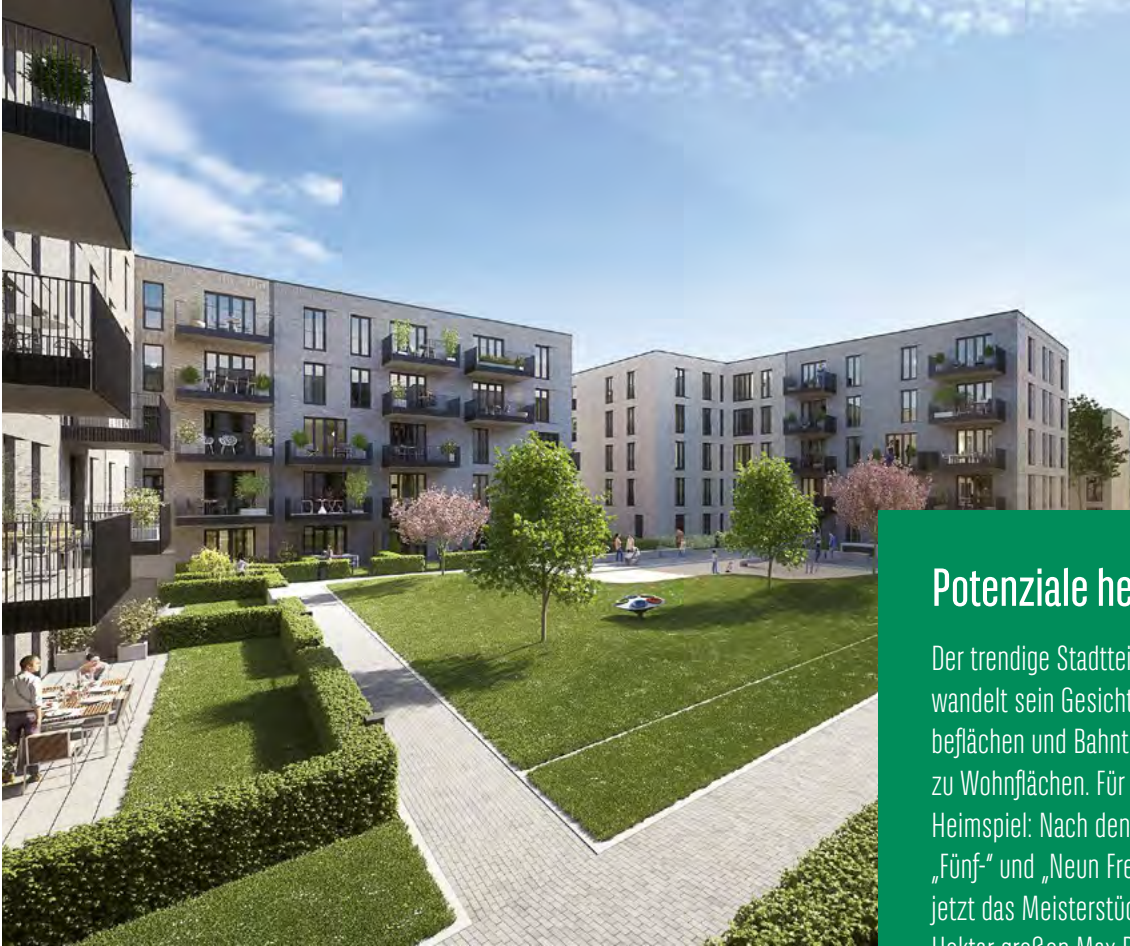
Schlag auf Schlag: Mit dem zweiten Bauprojekt „Neun Freunde“ schafft Pandion im Kölner Ehrenveedel weitere 136 Wohnungen.
